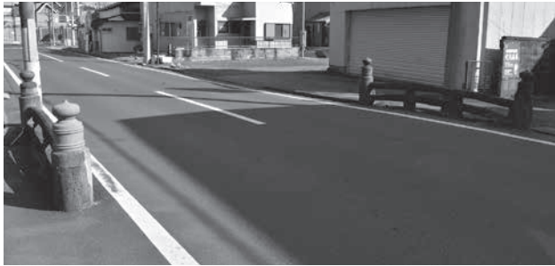
清善寺付近の新兵衛橋跡
