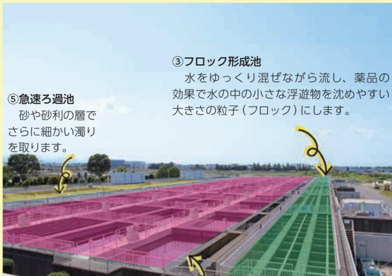
④薬品沈でん池 フロックを池の底に沈め、水の汚れを取り除きます。傾斜版式沈でん池により、汚れを効率的に沈める構造になっています。ここで沈でんした泥は、脱水処理後「浄水発生土」としてセメントの材料などに利用されています。
