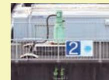
②急速かくはん池 水の汚れを固める薬品(凝集剤)を加え、勢よく混ぜ合わせます。
