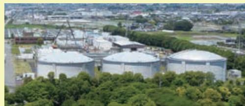
⑥浄水池、送水調整池 出来上がった水は一度地下にある「浄水池」(貯水量5万2千立方メートル)に貯められます。また、災害時にも水がすぐ使えるよう地上にも「送水調整池」(貯水量6万立方メートル)を設置しています。
