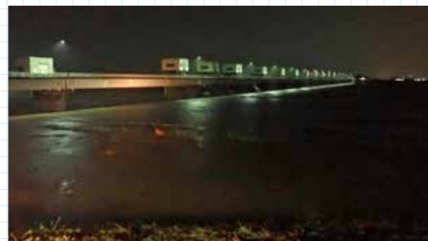
令和元年10月12日午後8時ごろ 須加地内(利根川)
