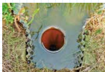
田んぼダム用フリードレーン(横穴付水位調整管)
