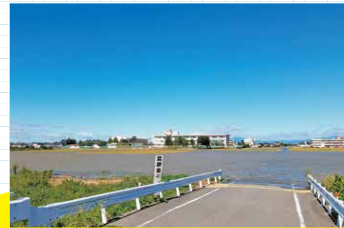
令和元年10月13日午前10時ごろ 長野地内(忍川)
