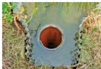
田んぼダム用フリードレーン(横穴付水位調整管)
