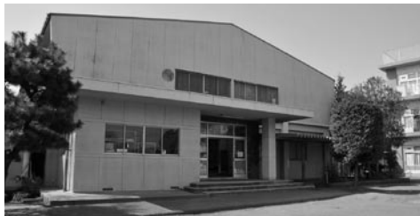
耐震補強・改修工事が行われる南河原小学校屋内運動場
