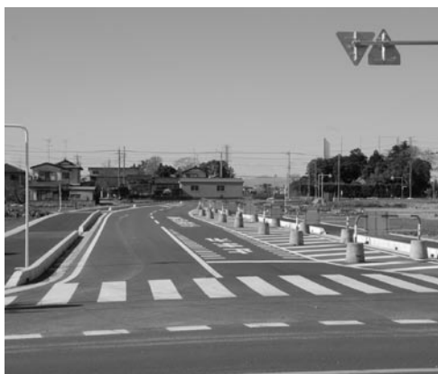
全線開通した（仮称）前谷下忍線
