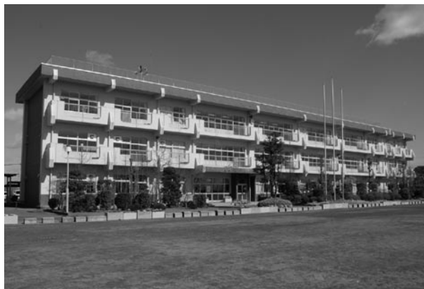
内外装改修工事を行った南河原中学校
