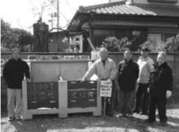
とても喜ばれているコンクリート製のごみ集積所
