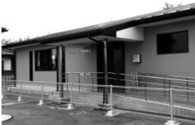
新たに設置された埼玉学童保育室
