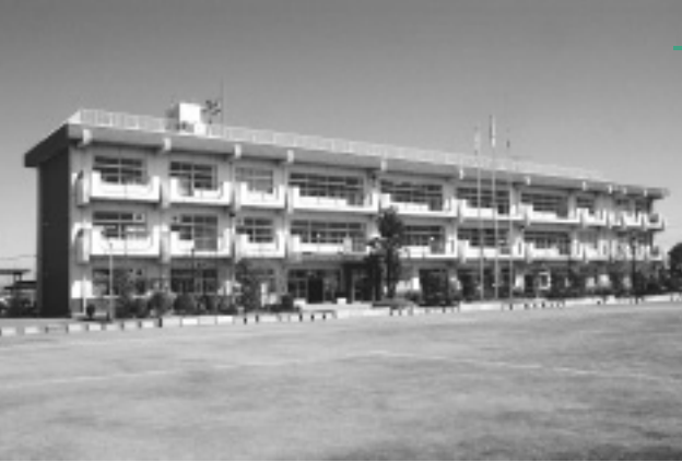
給食用エレベーターの整備を行う南河原中学校
