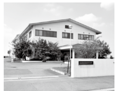
妻沼南河原環境浄化センター
