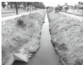
がんがら落排水路
