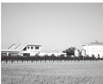
南河原浄水場
