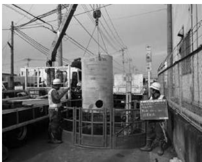
下水道工事（藤原町地内）
