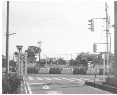
武蔵水路・橋梁架け替え工事
