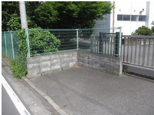
ブロック塀3段の上にフェンス
