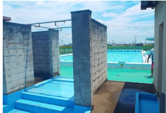
プールシャワー部
