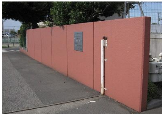
鉄筋コンクリート製の塀
