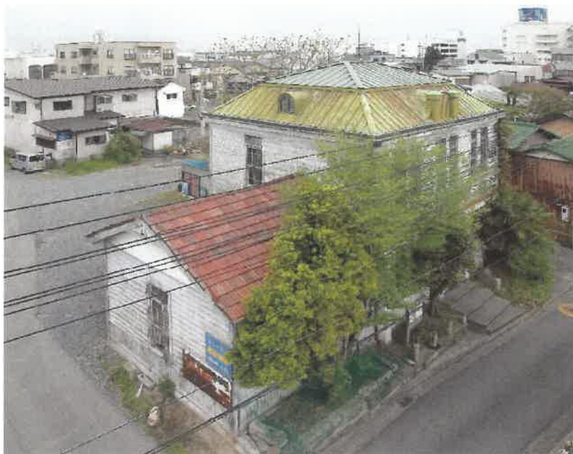
修理前の外観
