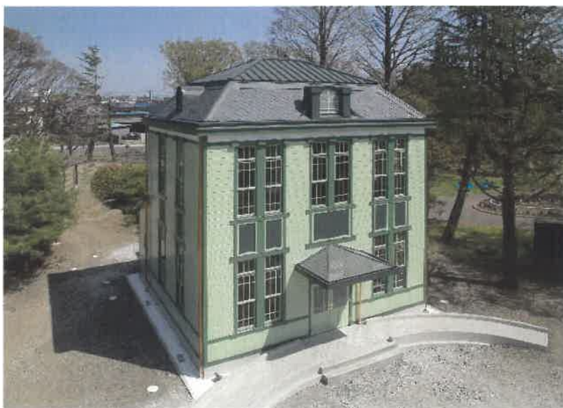
復元整備後の外観
