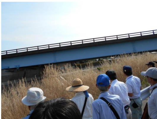
【忍川・新忍川新橋（バイパス高架下）】
