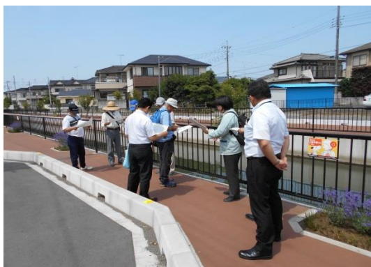
【酒巻導水路・整備済区間】
